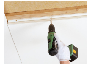
Master F é instalado através de fixação por parafuso
