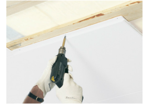
Fixation avec vis
