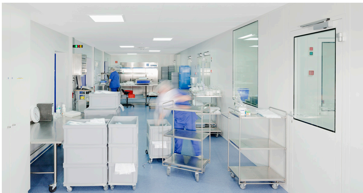
Pharma Labor-Vorbereitung, Greven, Germany
