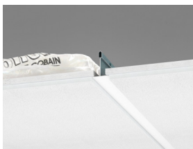
Sezione del sistema Gedina E + Extra Bass
