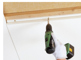
Master F rögzítőcsavarral rögzítve
