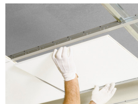
Pojedyncze płyty są łatwo demontowalne
