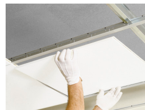
Pojedyncze płyty są łatwo demontowalne
