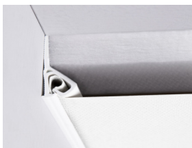
Clipso griestu uzstādīšana ar PCW profilu.
