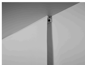
Clipso uzstādīšana pie sienas ar PCC profilu.
