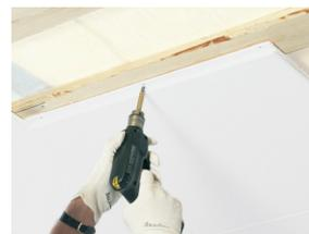
O Focus F é instalado por fixação com parafusos
