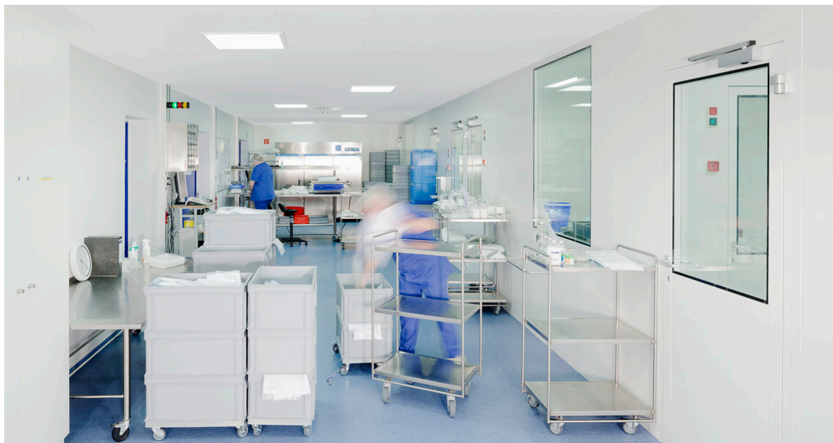
Pharma Labor-Vorbereitung, Greven, Germany
