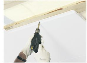
Focus F é instalado com fixação de parafuso
