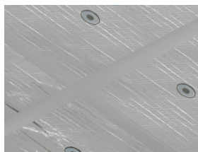
Industry AL -järjestelmä ruuvilla ja aluslevyllä.
