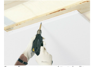
Focus F asennetaan ruuvikiinnityksellä.
