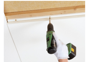
Master F è installato con fissaggio a vite.
