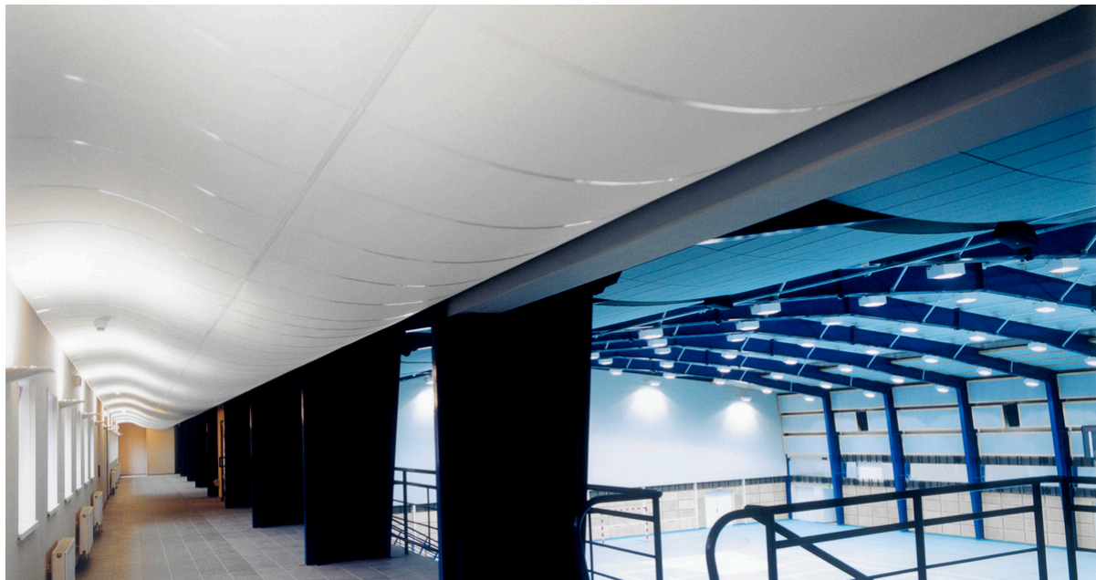
Mięjska Sala Widowiskowa Sportowa, Keplero, Poland
