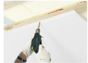
Fijación mecánica de las placas Focus F
