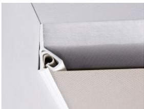
Techo Clipso instalado con perfil PVC y absorbente.
