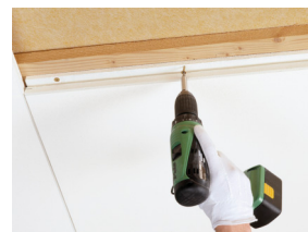
Instalace Master F pomocí šroubů
