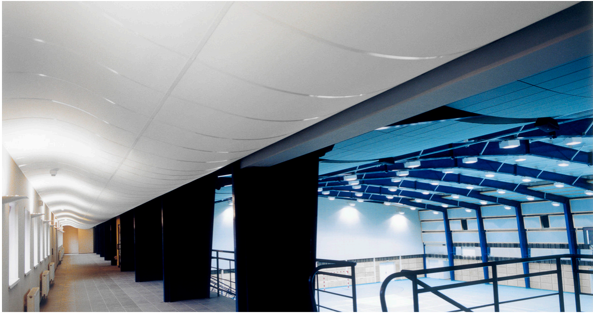
Miejska Sala Widowiskowa Sportowa, Keplera, Poland
