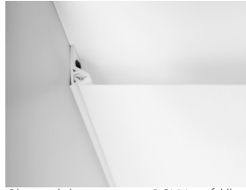
Clipso alakattoasennus PCW-profiililla.
